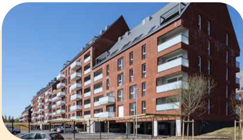
Marquette-lez-Lille Site des Grands Moulins de Paris Avenue Decauville MILLEO
